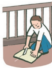
防水シートを傷つけないように注意。
